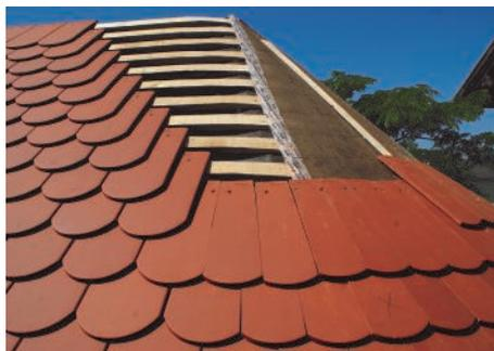
Dachziegel wurden am kegelförmigen Dachstuhl montiert. Das kann nie dicht sein. Der Dachdecker hat deshalb in mühevoller Kleinarbeit die neuen Ziegel in der Rundung geschnitten, damit diese korrekt überlappen.
